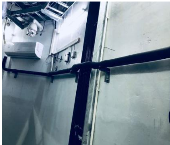
GPPD 挂机、排水管安装
