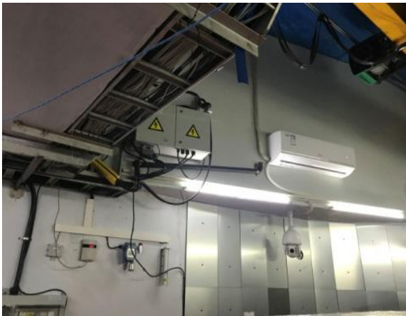
MR室内机、排水管安装
