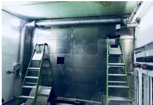
散射室内管路施工
