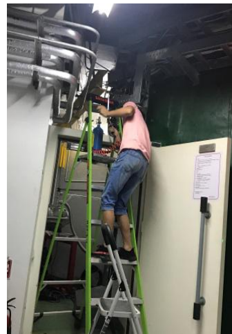
SANS 冷媒管安装
