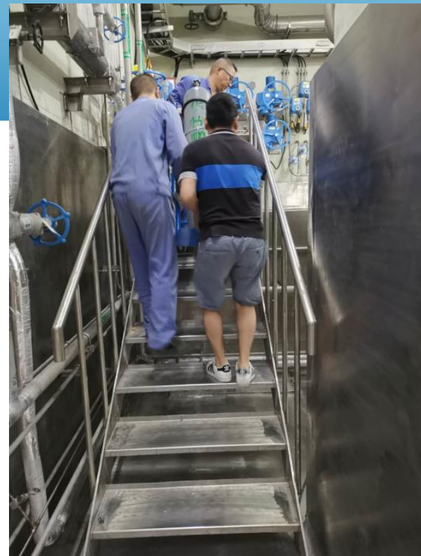
打压氦检改造前的状况
