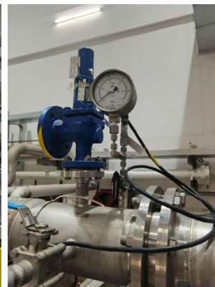
压缩机回气管 仪表与安全阀
