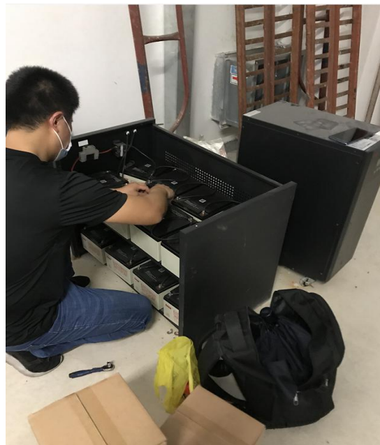
更换UPS蓄电池
