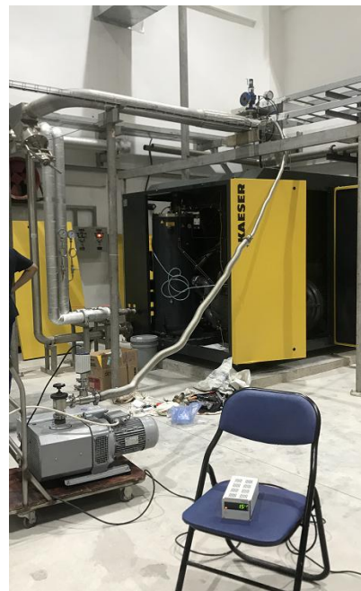
压缩机管路抽真空
