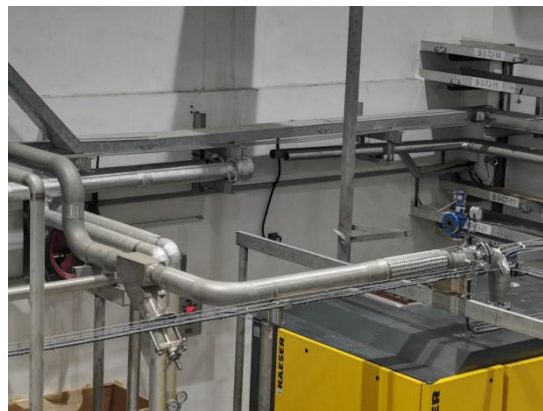
压缩机回气管
