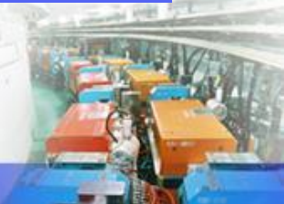
直线速调管水冷泵房
