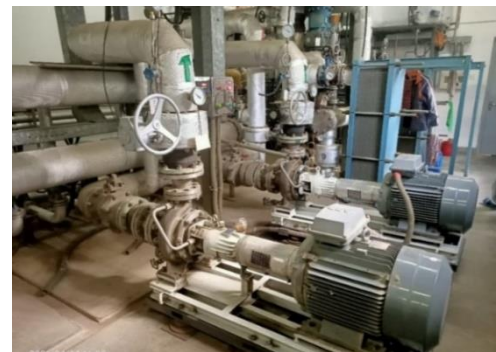
直线速调管水冷泵房
