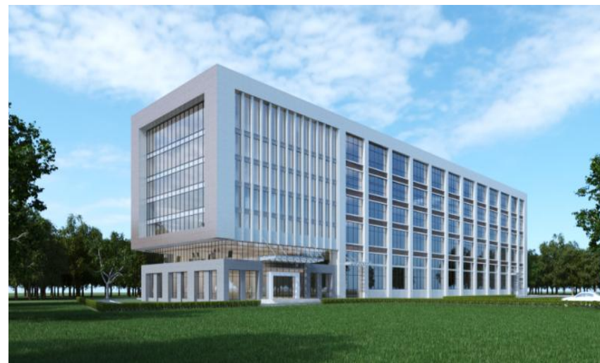
公司二期扩建生产线
