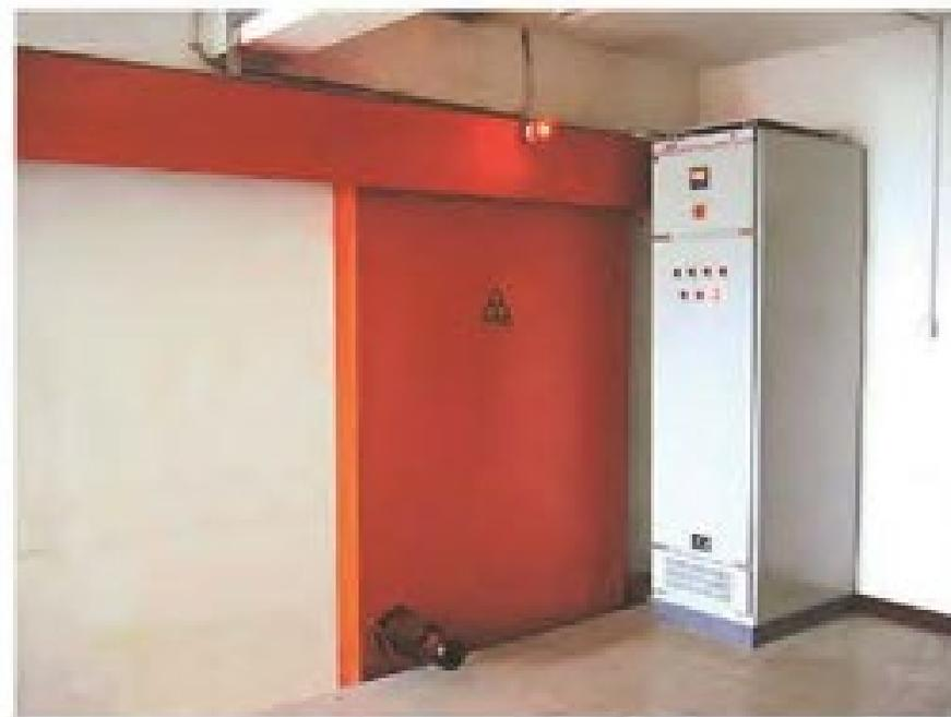
450KV射线防护门，3800\*4400/1600\*2300mm，天津（2009）
