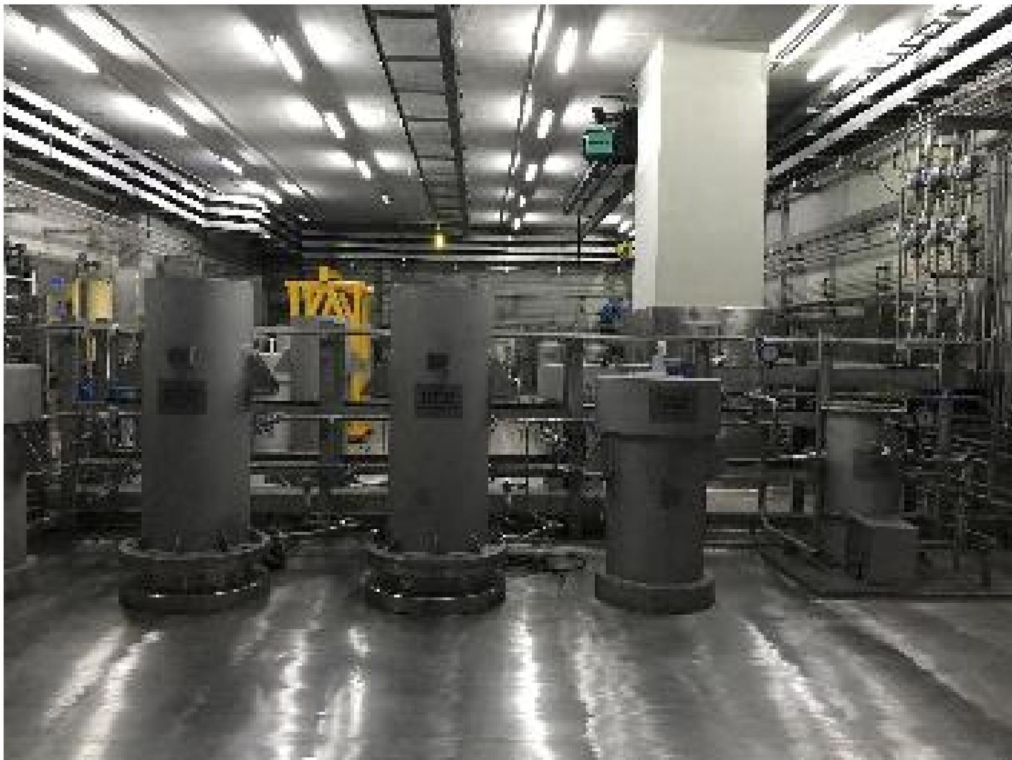
CSNS靶站水冷却系统净化设备的屏蔽容器，广东（2015）
