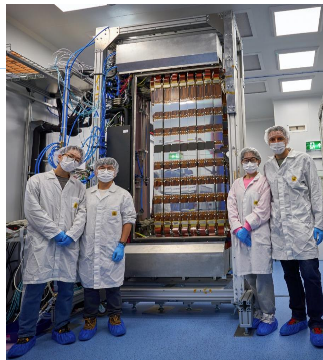
最后一个stave安装完毕
