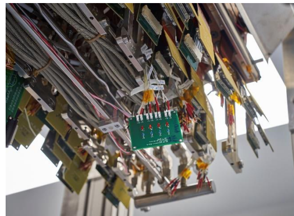
HV test boards & HV pins
