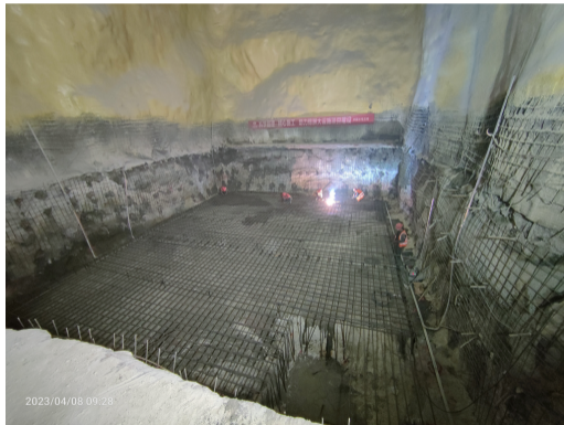
图：墙面支护完成
