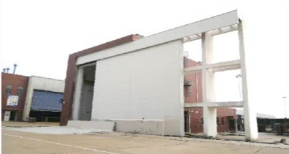
大型铅钢电离辐射防护门（水平拼装）
