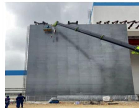
超大型电离辐射防护门，2500T，辽宁（2022）
