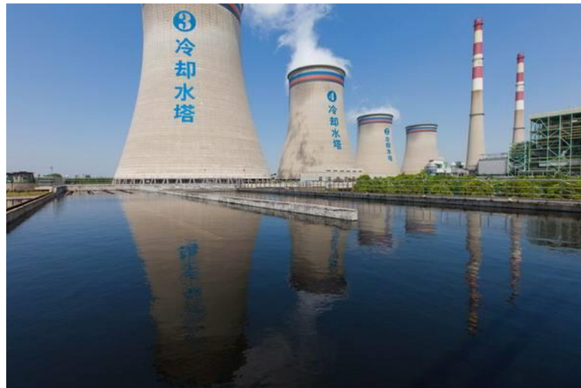
图2 典型冷却水塔
