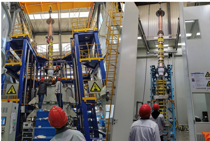
优化了后道工艺，水路安装及线圈水套安装更加科学顺畅
