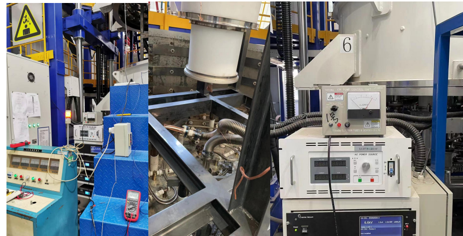
阴极激活及发射度测量，发射电流16.55mA@1kV，管芯钳口，管内真空度维持在 3.5 \times 10^{-8} Pa
