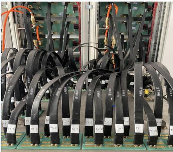
2: 从放电单元至脉冲变压器油缸采用我公司研发的连接端子技术将分布电感控制在30nH以下
