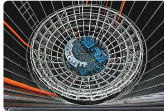
广东江门中微子实验站建设现场。 刘悦湘摄
