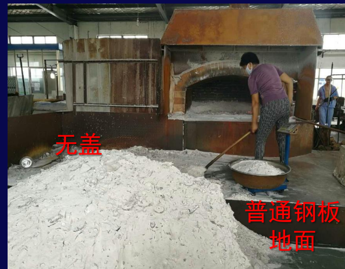
加料口，向炉内投入原料
