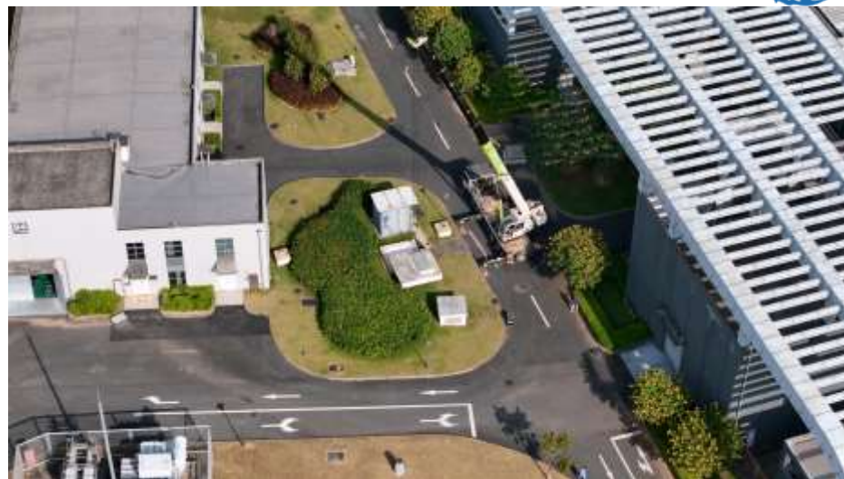
单束团实验设备吊装现场
