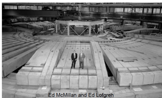
图 35: 基于弱聚焦原理建造的 Bevatron。
