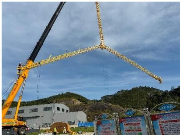
检查工装在地面进行试装和测试
