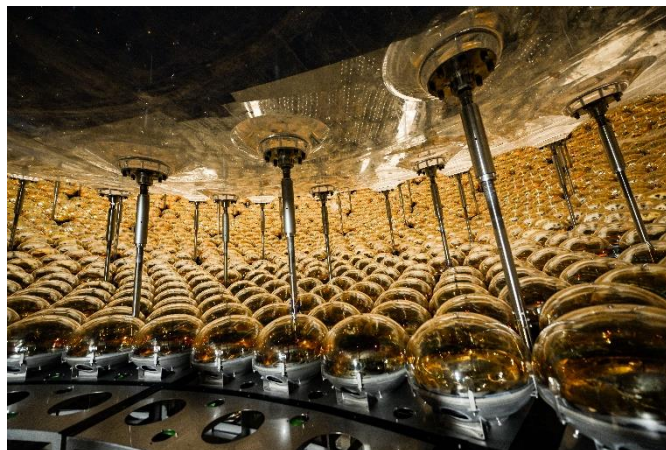
PMT安装基本完成
