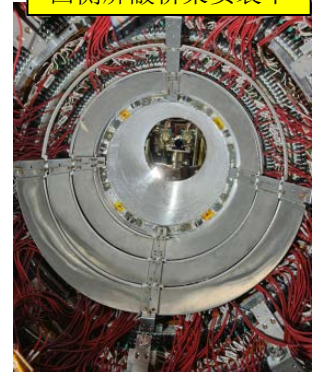
(CGEM安装前) 西侧屏蔽桥架安装中
