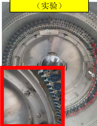
内室端部插件安装 (实验)
