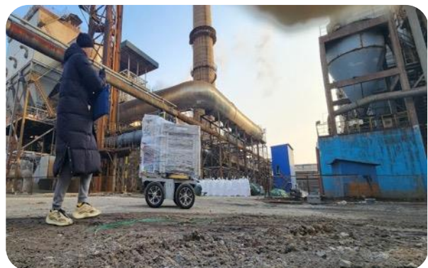
河南钢铁公司2号高炉三维成像
