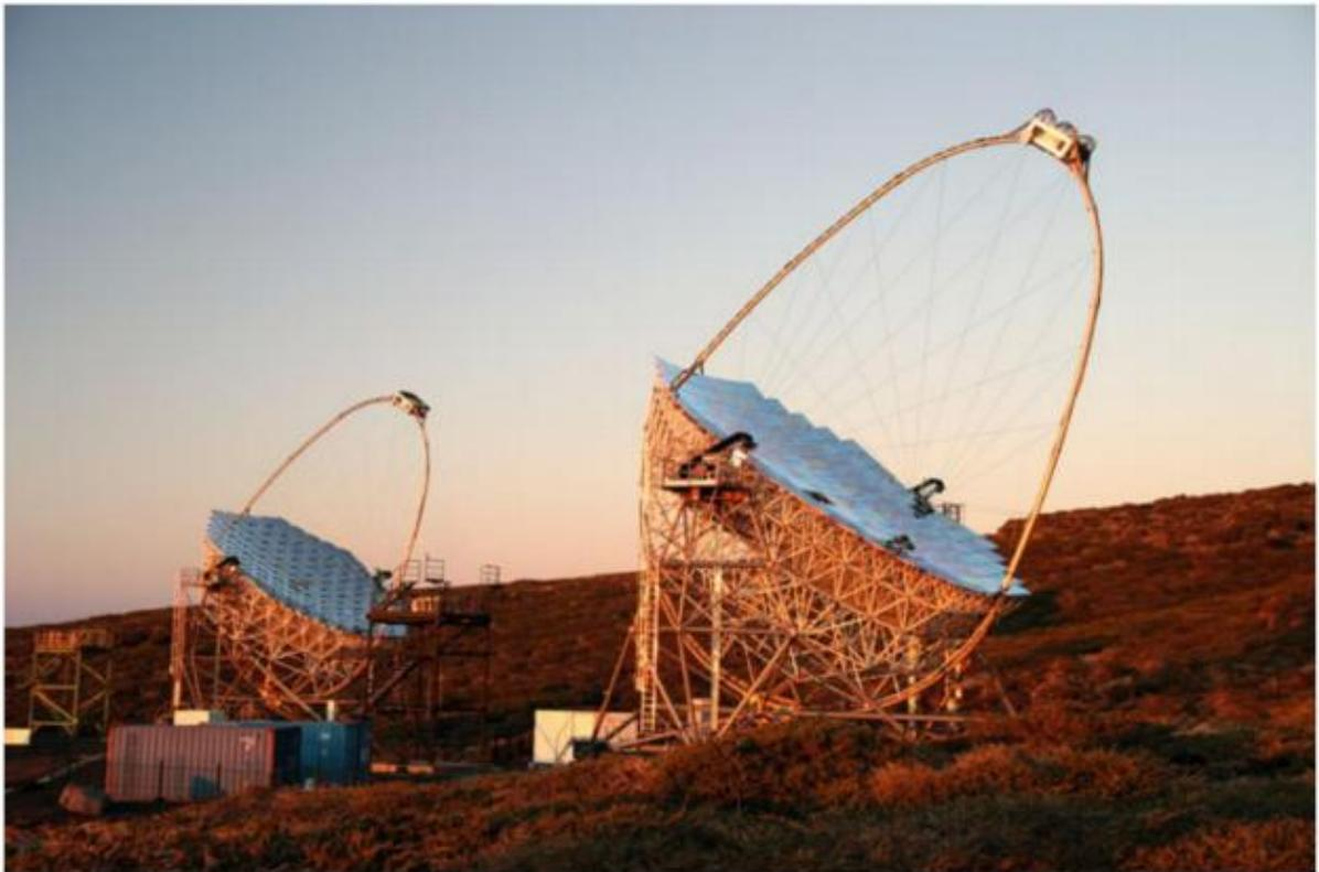
图 6.56 位于西班牙拉帕尔马岛的 MAGIC 切伦科夫望远镜;最大的望远镜的镜面直径为 17 米(MAGIC=主要大气伽马成像切伦科夫望远镜);经 MAGIC 的 Razmik Mirzoyan 友情许可[87]
