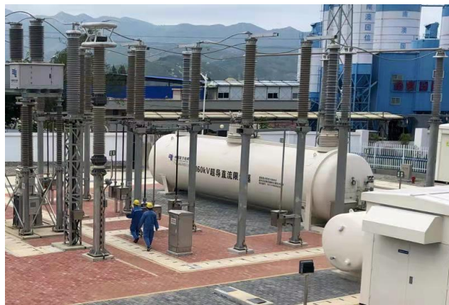
2025年5月，南方电网汕头南澳岛 160千伏超导直流限流器 挂网运行。
