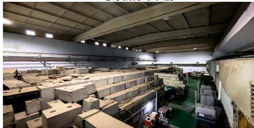
10号厅拆除吊装前
