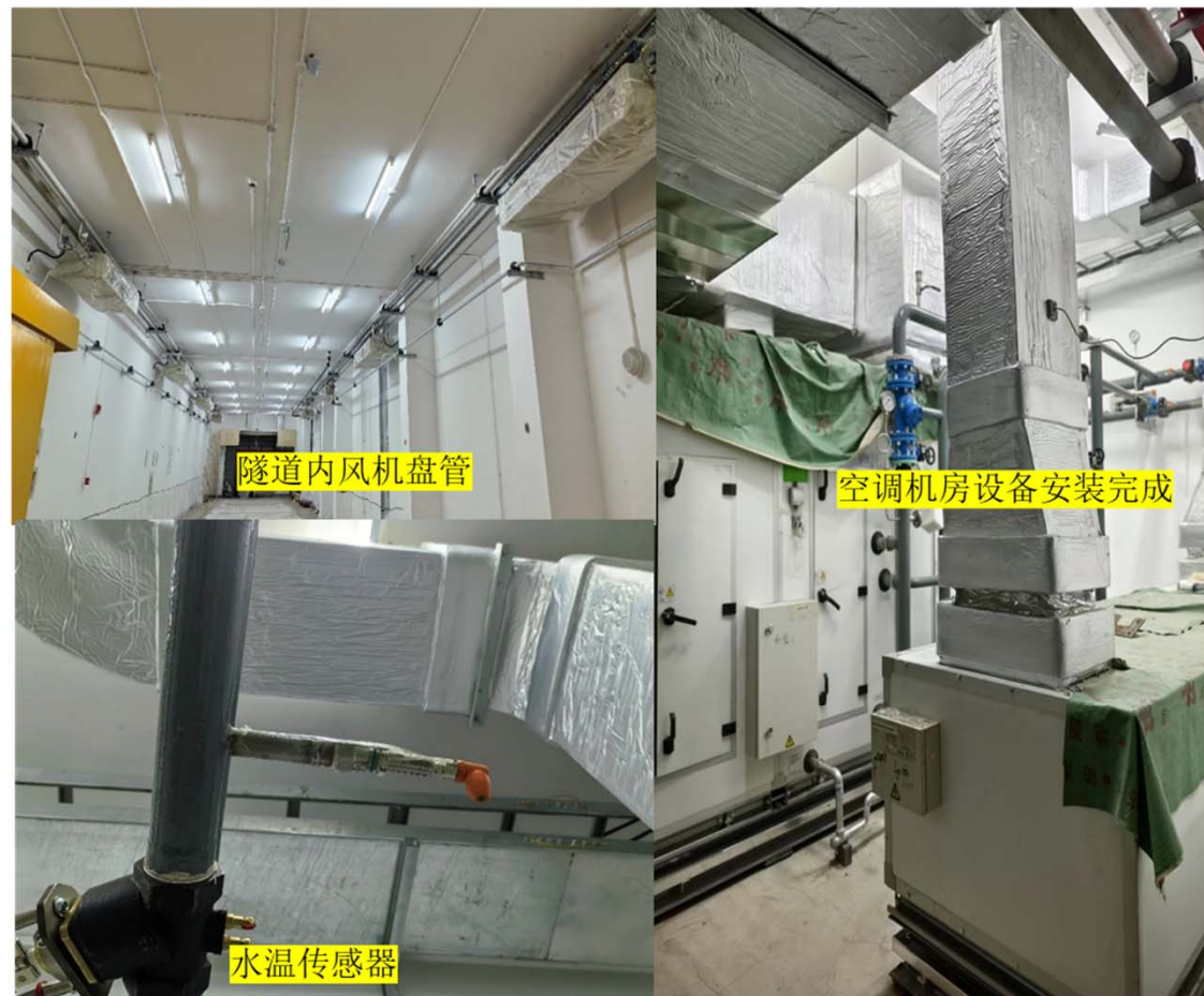
空调系统安装完成情况
