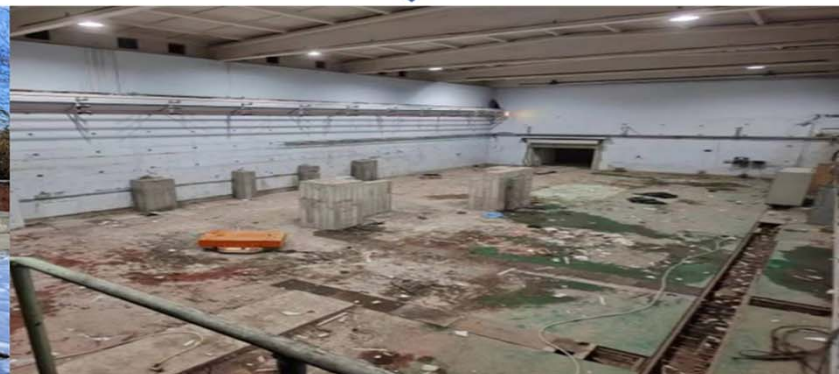
10号厅拆除吊装后
