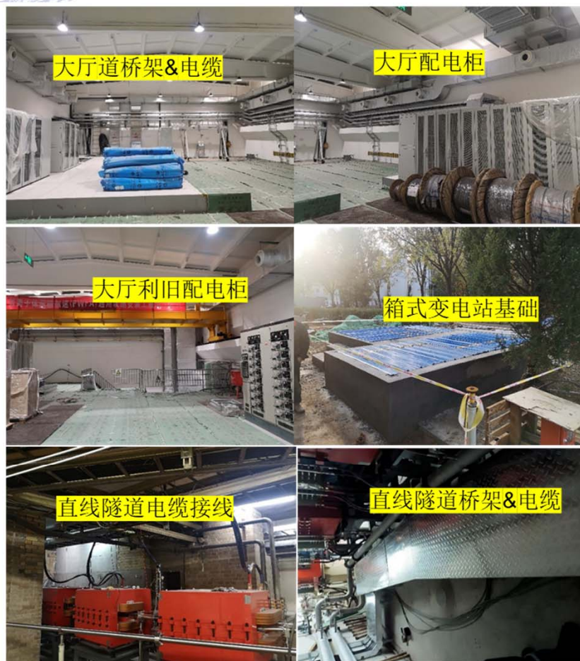
供配电系统安装完成情况
