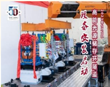
2023年2月1日 储存环隧道设备安装启动
