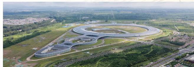
2023年11月3日 配套楼建筑通过五方验收
