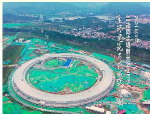
2021年6月27日 主环建筑单体封顶
