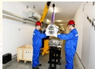
2021年6月28日 首台科研设备开始安装
