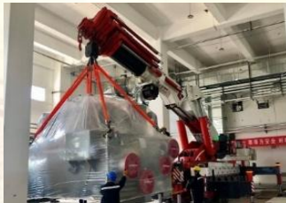
2021年4月13日 通用设施集成安装启动
