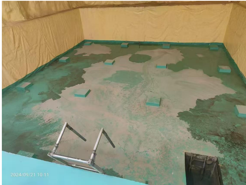
D2厅实验基坑完成
