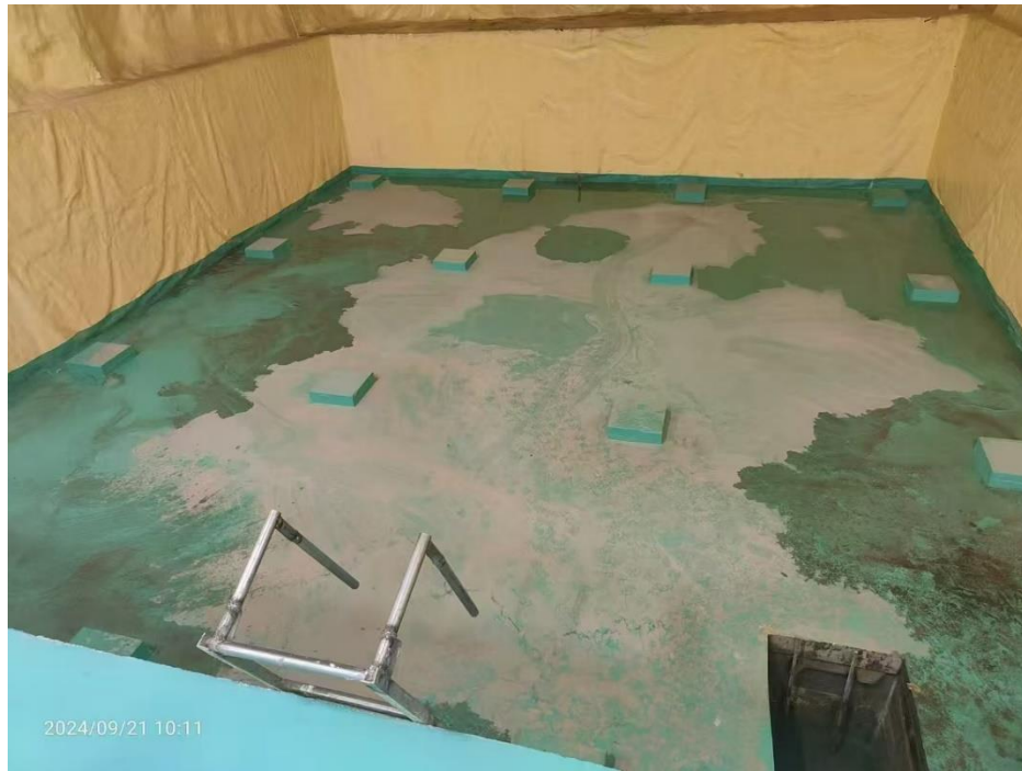
D2厅实验基坑完成
