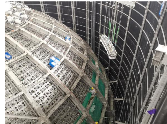
PMT模块安装（上半球）
