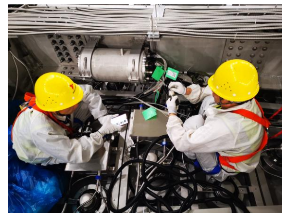
3-inch PMT电子学安装
