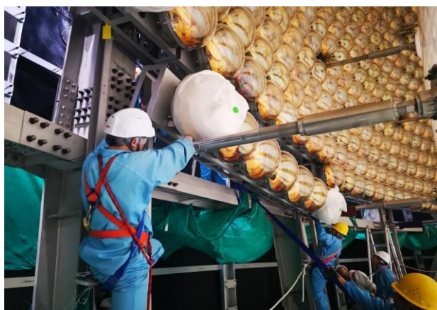
PMT模块安装（赤道）
