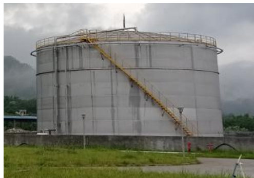
5000 m 3 LAB 存储罐
