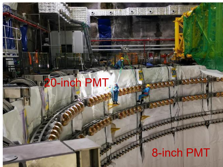
水池壁PMT安装
