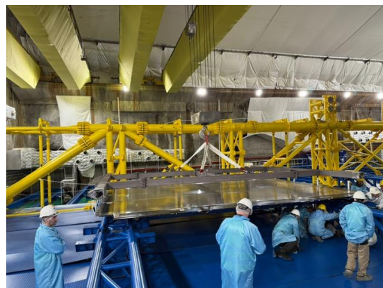
顶部径迹探测器安装
