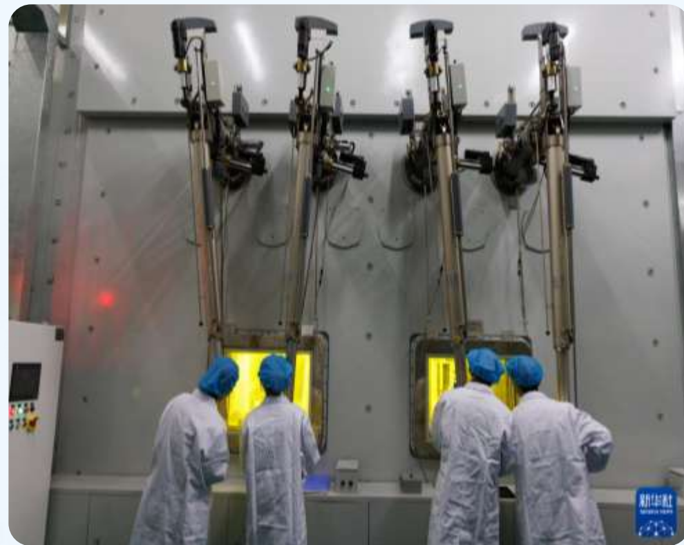
图示：2兆瓦液态燃料钍基熔盐实验堆厂房
