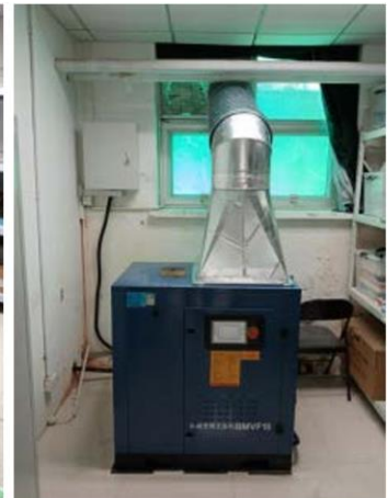
空压机散热口专门的排风管道
