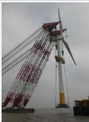
图片来源：上海东海大桥海上风机吊装
