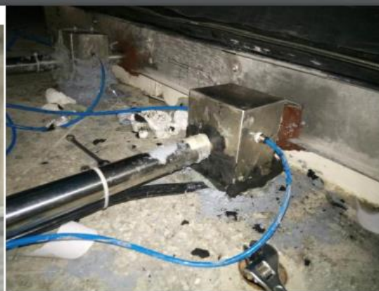
液管接头处加氮气保护
