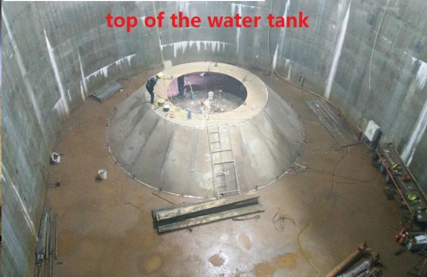
超纯水不锈钢罐体建设
